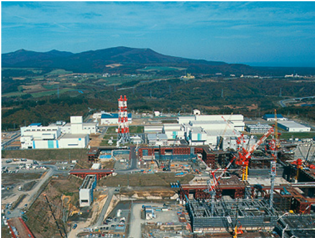
建設中の六ヶ所村原子燃料サイクル施設 (1997年10月撮影、提供：日本原燃)
