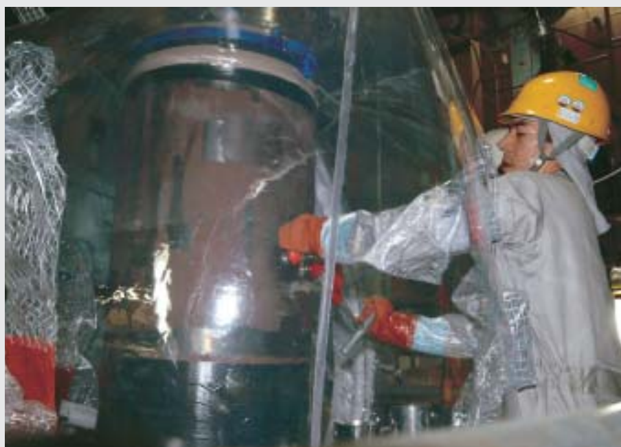
温度計交換作業 (原子力機構写真提供)
